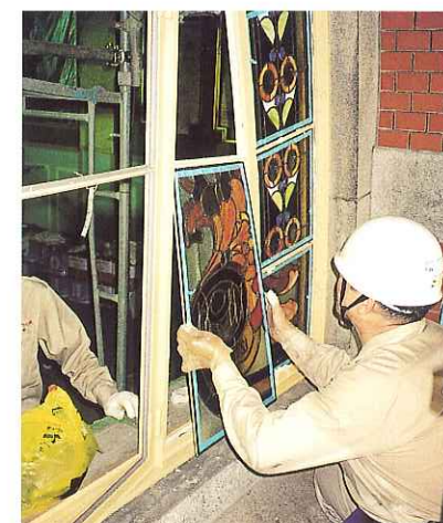
特別室 ステンドグラスの修復
