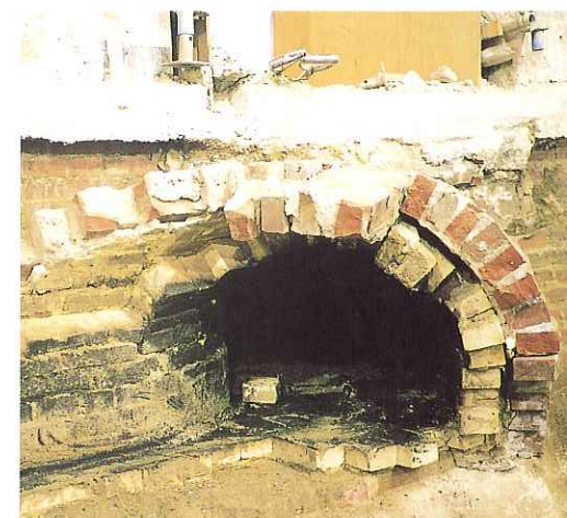
土中より見つかった煙道の一部(地下1階に展示)
