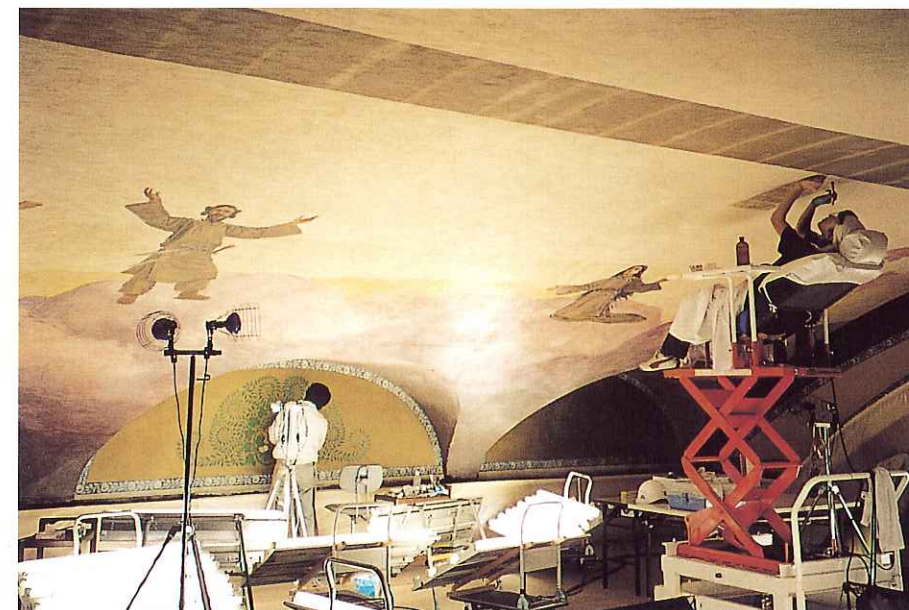
特別室 天井画の修復
