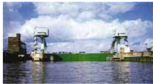
閉鎖した尻無川水門
